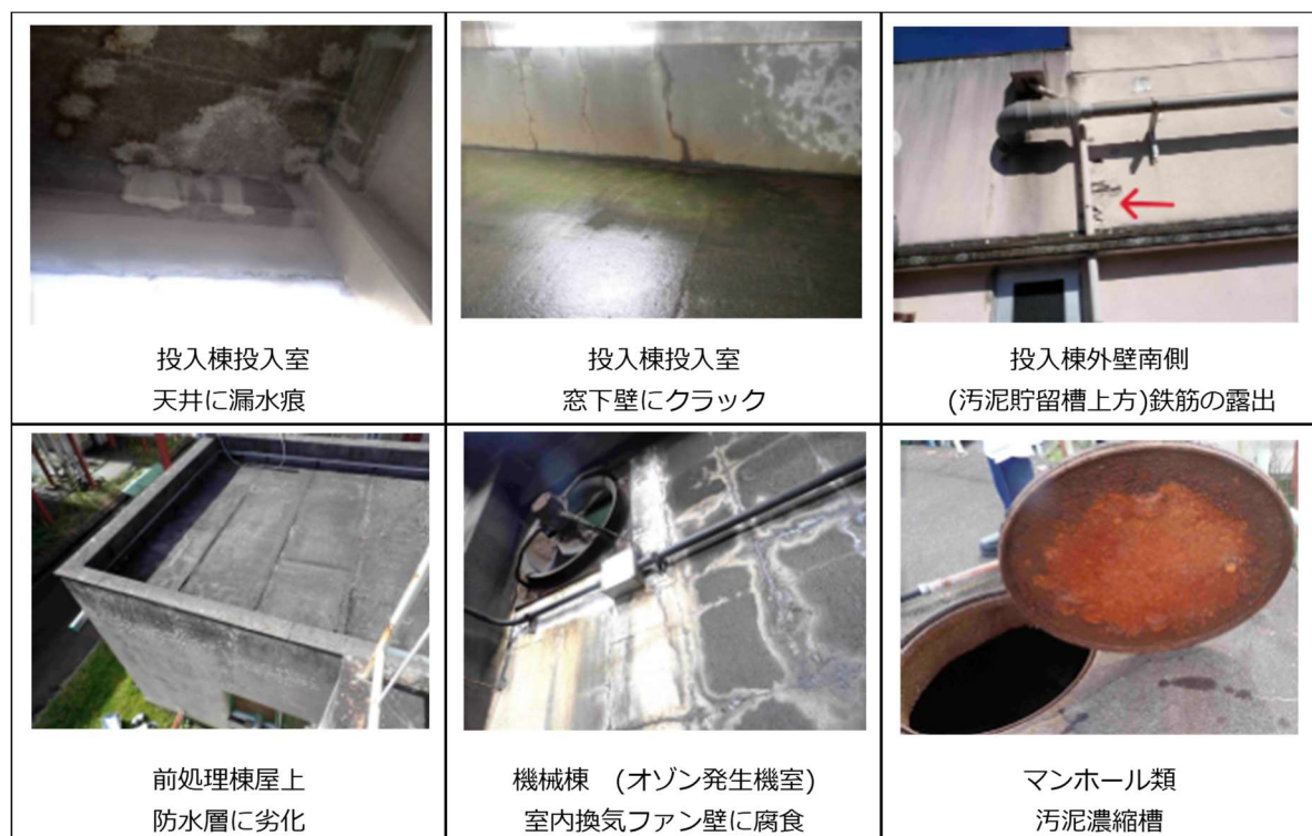
図 8 計画的に補修が必要な建築設備
