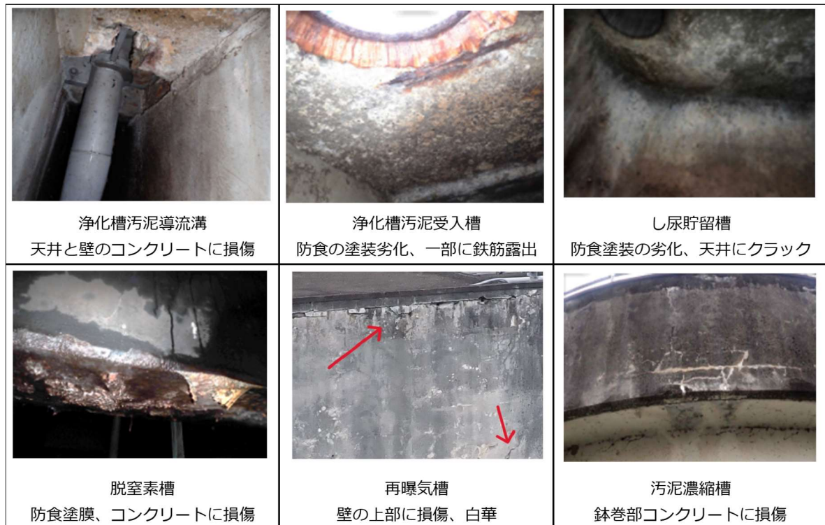
図6 計画的に補修が必要なRC水槽
