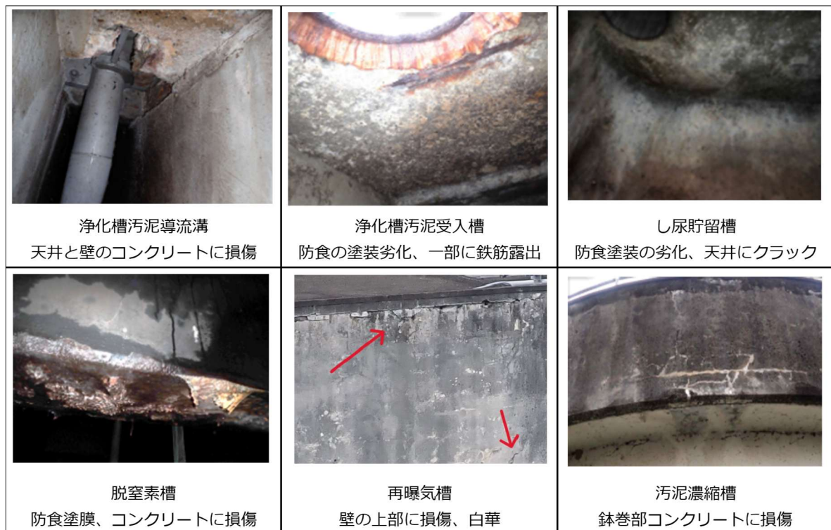
図1.3.2 計画的に補修が必要なR C水槽
